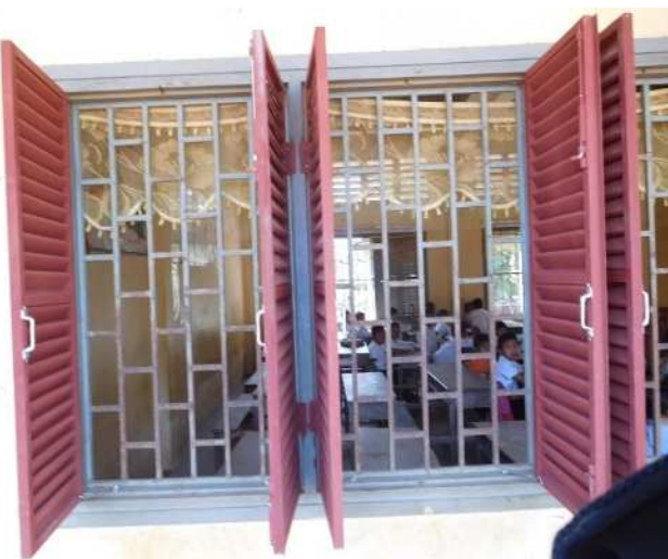
新しいスチール製窓
