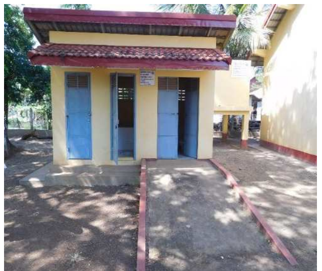
1棟3室のトイレ
